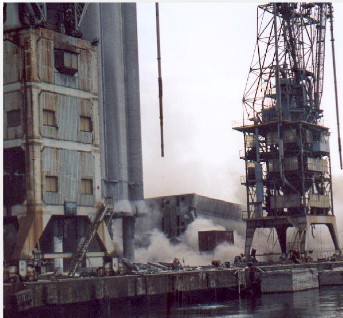
Figura 18 | Demolizione silos granari Ponte Parodi – Genova
