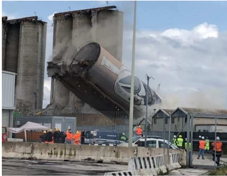
Figura 20 – abbattimento silos della Silos Granari della Sicilia Porto di Ancona
